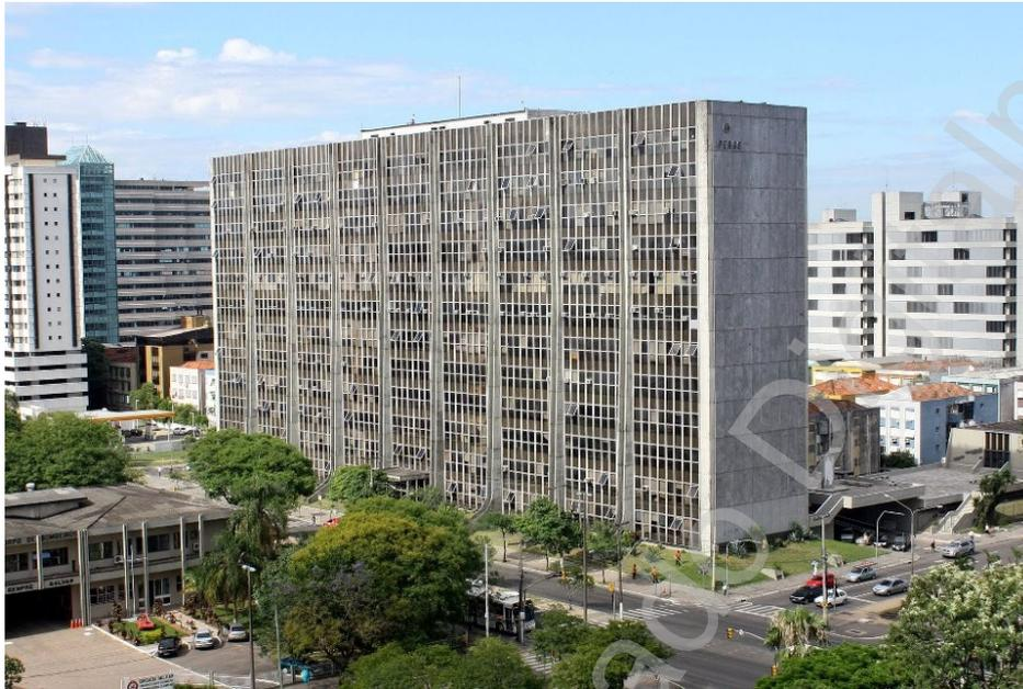
**Imagem 01:** Fotografia onde podemos ver a fachada do Instituto e o seu sistema de fachada em vidro do tipo comum aplicado sobre caixilharia de alumínio.
